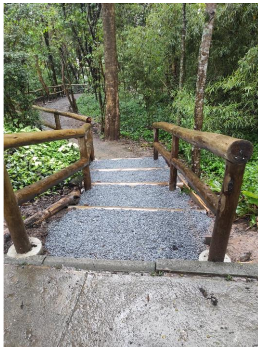
Figura 9: adequação da escada com guarda corpo rígido.
