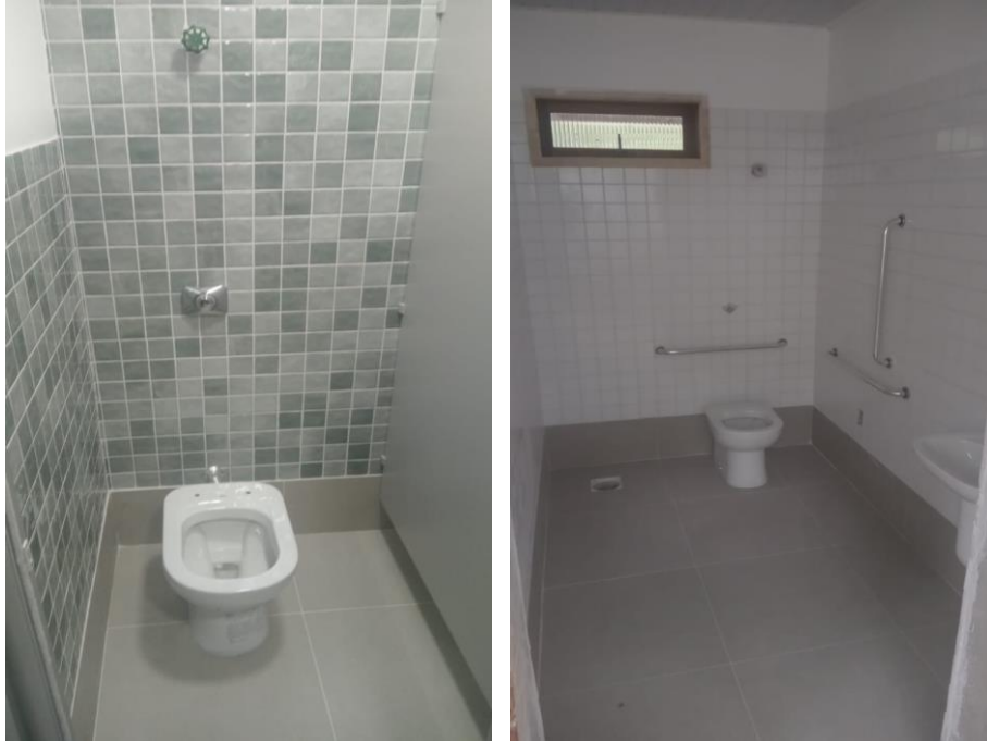
Figura 20: reforma dos banheiros
