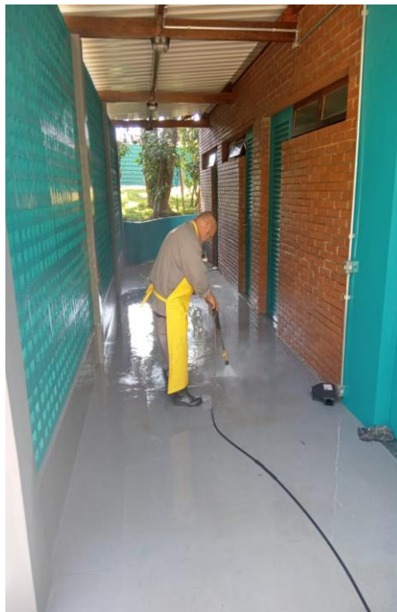
Figura 17: com lavadora de alta pressão.
