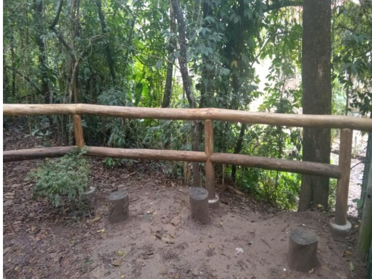
Figura 8: Guarda corpo rígido com eucaliptos tratado
